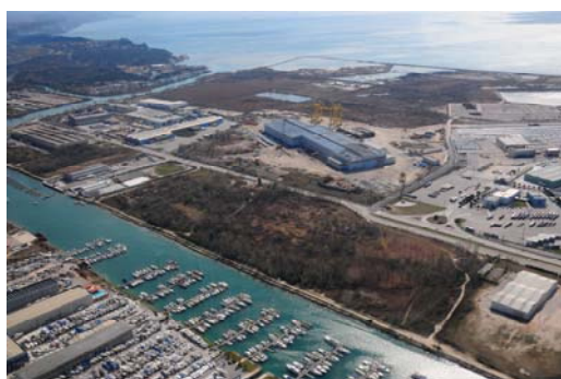
Fig. 33 – Corografia – area d'intervento di Via Consiglio d'Europa prima degli interventi di bonifica ed infrastrutturazione
