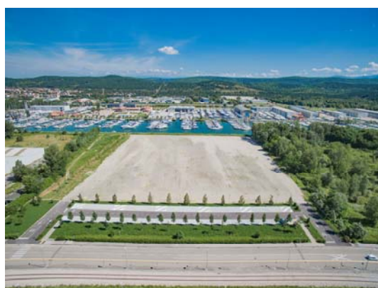
Figura 34 – dopo gli interventi di bonifica ed infrastrutturazione (foto giugno 2016)
