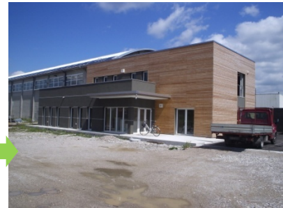
3) recupero edificio dismesso
