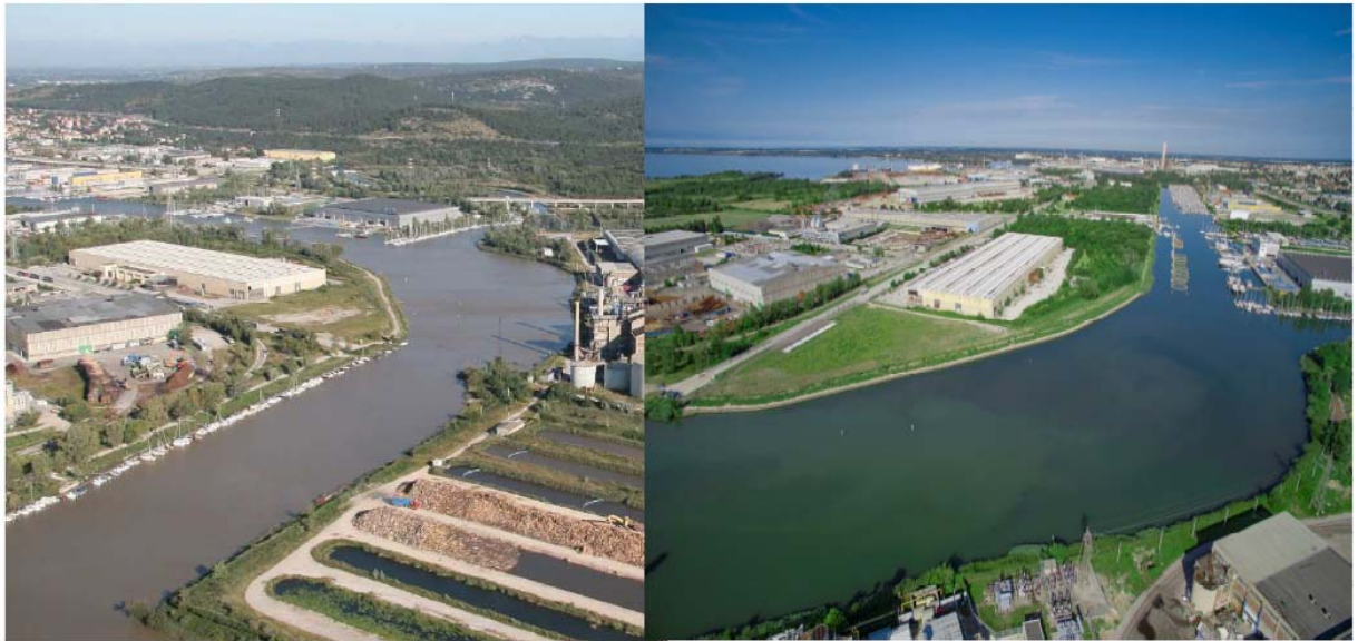
Fig:15 Opere di bonifica ed infrastrutturazione per attività produttive in Z.I. Lisert Nord – nel 2015 sono stati collaudati i lavori di messa in sicurezza degli argini del Canale Est-Ovest e nel 2016 sono stati rimossi alcuni relitti di barena.
